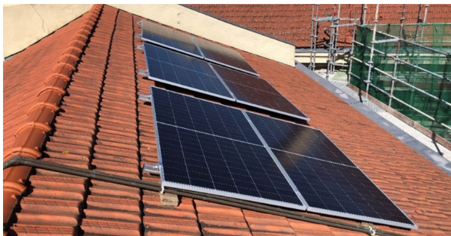
Placas solares instaladas en el tejado del conjunto edificatorio de TorreUrizar. Fuente; VMM
