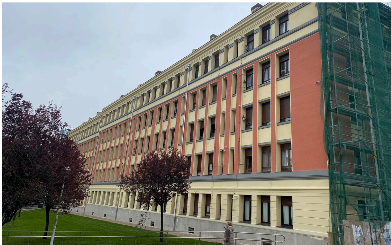
Hiri-berroneratzeko obren ondoren, TorreUrizar etxebizitzaren kanpoaldearen egoera. Iturria: Bilbao Etxebizitzak
